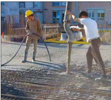
⑦ 2 nd STAGE OF THE CONCRETE POUR
