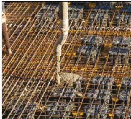
⑤ 1 st STAGE OF THE CONCRETE POUR
